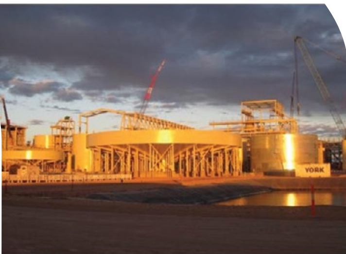
The SA Processing Plant
